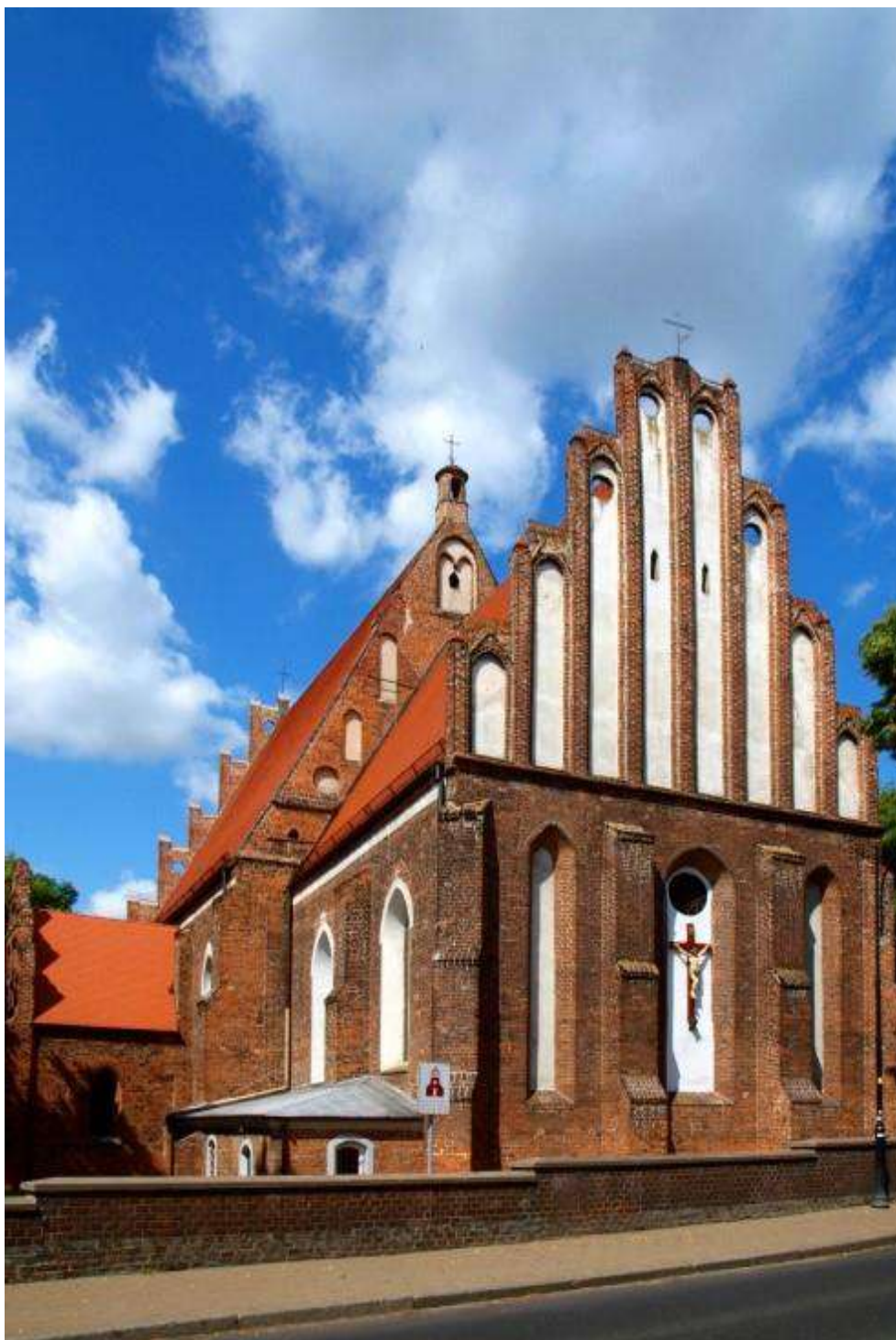
Kolska Fara. Widok na prezbiterium. Po lewej stronie kaplica NMP.
